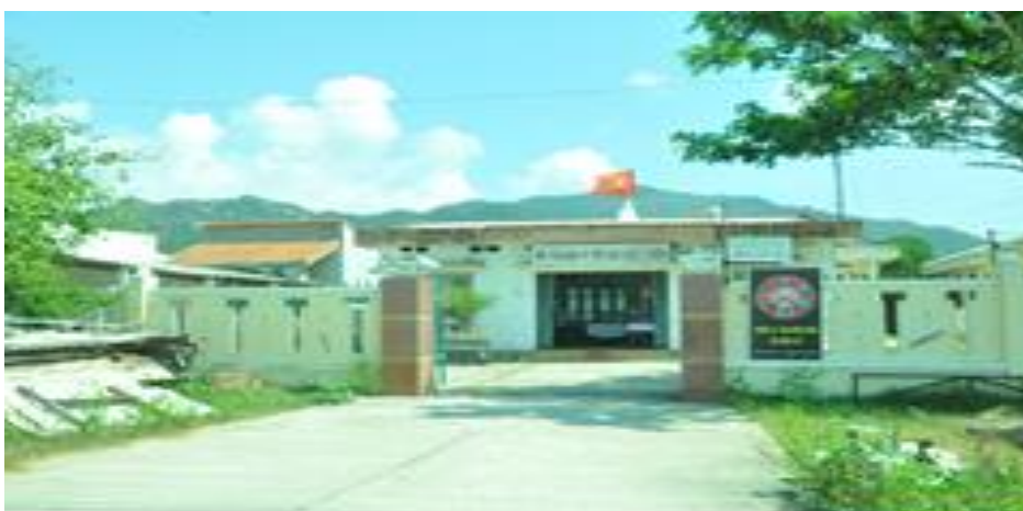
Trạm y tế xã Cát Tiến
